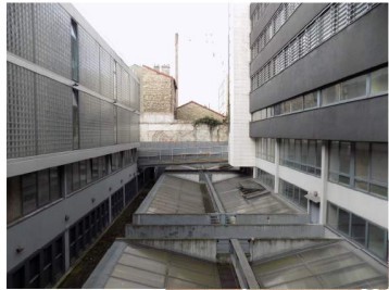
Batiment A, le bâtiment avec pavés de verre et la verrière
