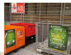
Tri des déchets sur le chantier du futur lycée
